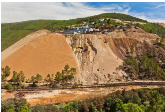
Antiga Lavaria do Rio e depósito de rejeitados sobre o vale do Zêzere, com erosão acentuada das vertentes e amostrassinais de drenagem mineira ácida (2019).
