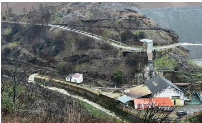
Fevereiro 2026, descarga e rib.a do Bodelhão à esquerda, ETAM e ravina com drenagens provisórias, novo muro de contenção e acesso à direita
