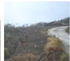
Aspeto final da vala de cabos
