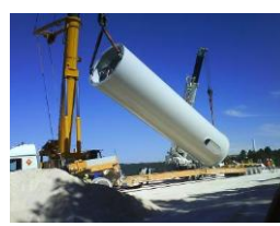
Montagem da torre do aerogerador
