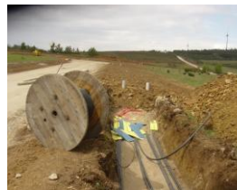
Colocação dos cabos
