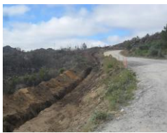
Abertura da vala
