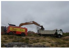
Remoção da terra vegetal das faixas laterais (zona alargada)
