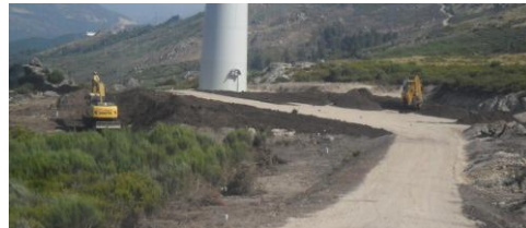
Trabalhos de requalificação da plataforma de montagem de um aerogerador
