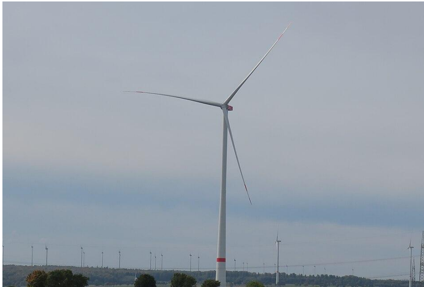
Aerogerador idêntico aos previstos instalar
