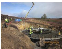
Execução da armadura da fundação do aerogerador
