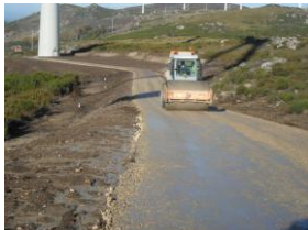
Trabalhos de compactação do acesso após requalificação dos taludes
