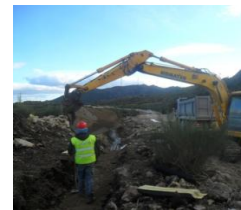
Fecho da vala
