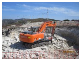
Abertura do cabouco para a fundação do aerogerador
