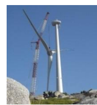
Montagem da cabina do aerogerador com as pás
