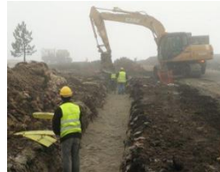
Execução da base em areia
