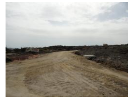
Aspeto de um caminho após colocação do material de pavimentação
