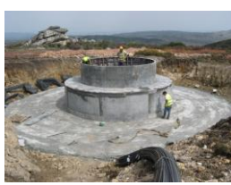
Betonagem da fundação do aerogerador
