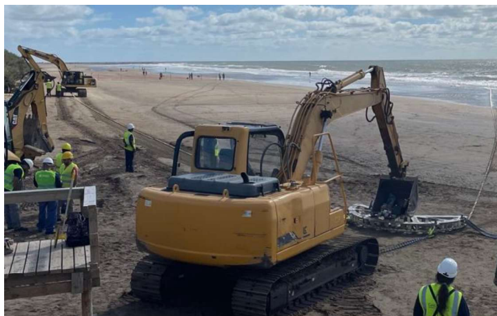
Figura 5.3.3 - Exemplo de aterragem com escavadora, em que a escavadora em primeiro plano segura um quadrante enquanto a escavadora em segundo plano puxa a linha mensageira.
